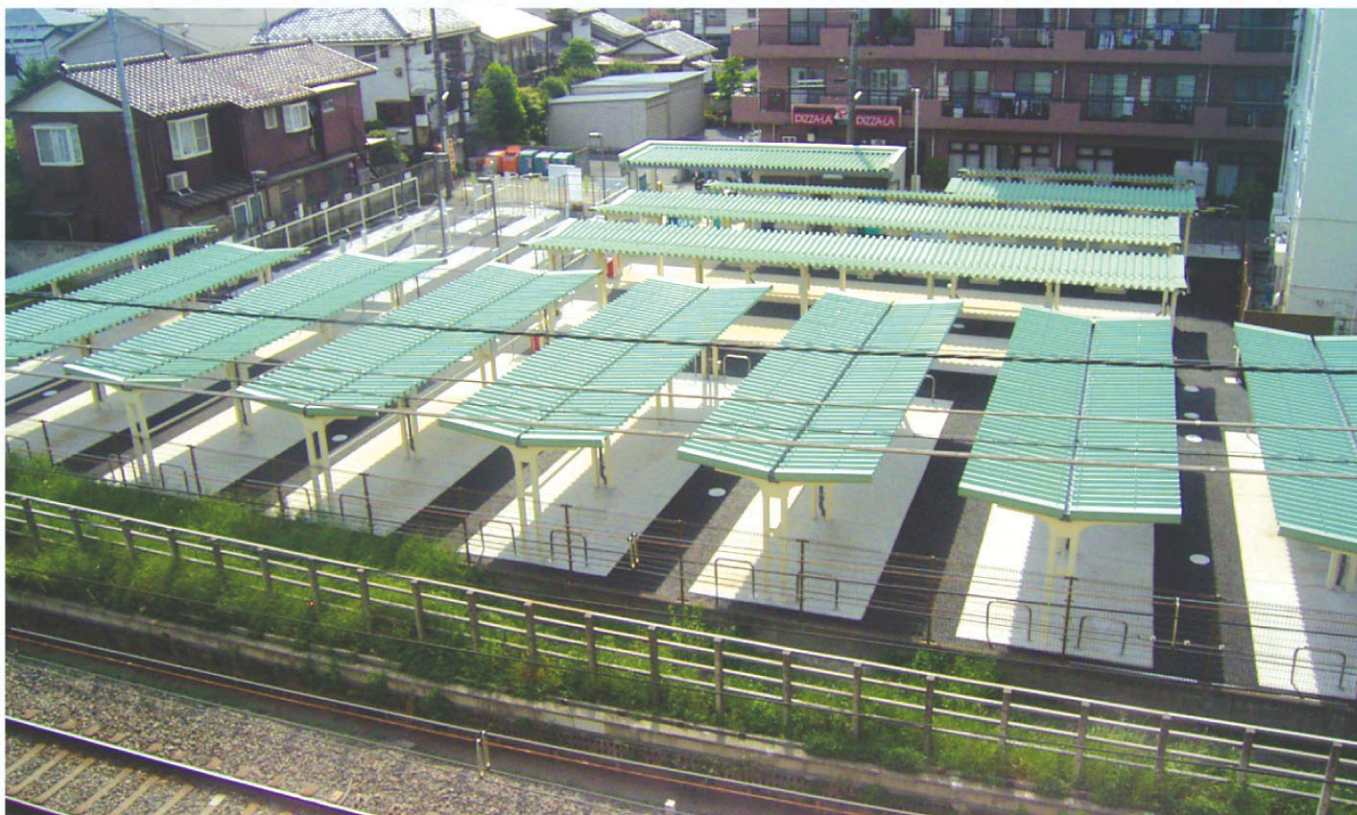
自動ゲート、防犯カメラ、照明を完備した安全で明るい分倍河原駅北第2自転車駐輪場
