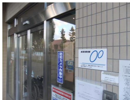
正面玄関の補助標識
