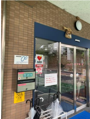
施設玄関（補助標識記事）
