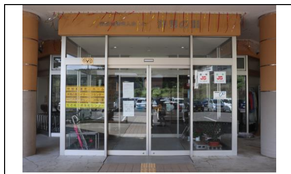
■ 機器を設置・使用している建物入口写真
