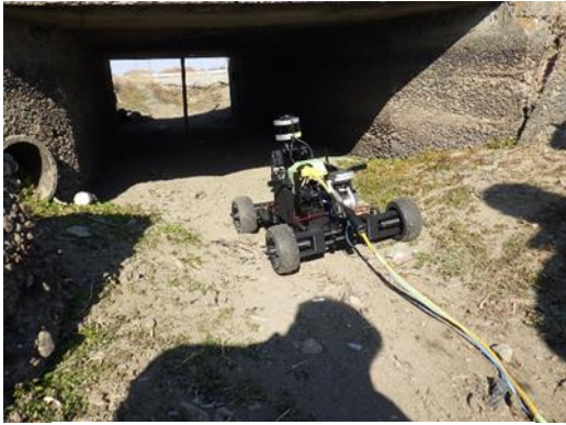
a. 橋下に進入する点検ロボット
