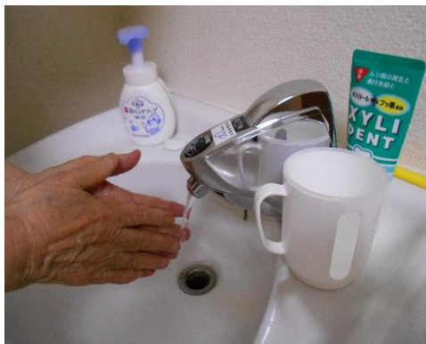
施設内の水道を自動水栓へ変更
