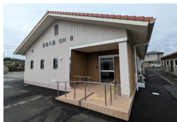
グループホーム住倉八島8棟 外観②
