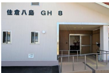
正面玄関周辺 (標識あり)
