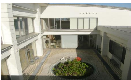
外壁補修（中庭）
