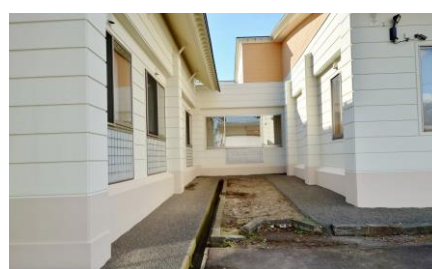
外壁補修（外観）
