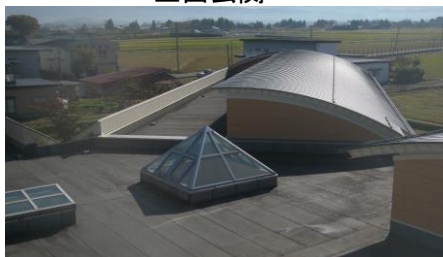
屋根補修（東棟）
