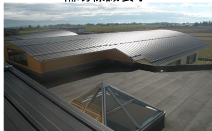
屋根補修（中央棟）
