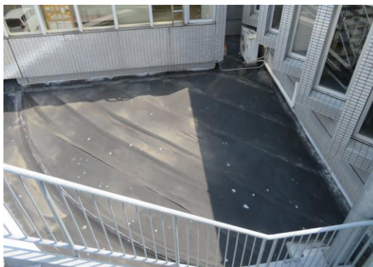
防水改修工事前
