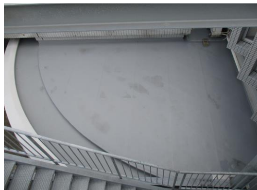
防水改修工事後
