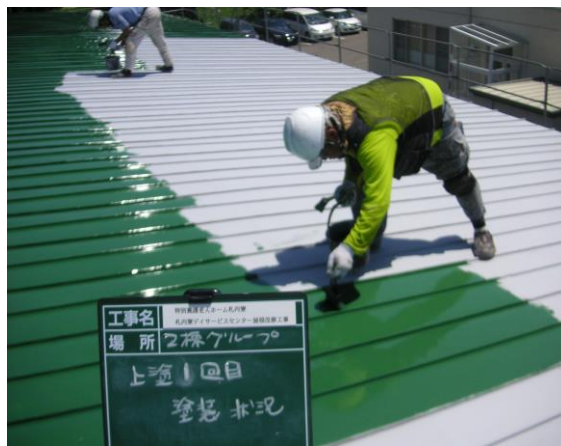
改修中 1回目塗装
