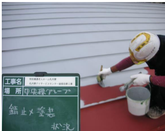
改修中 錆止塗装
