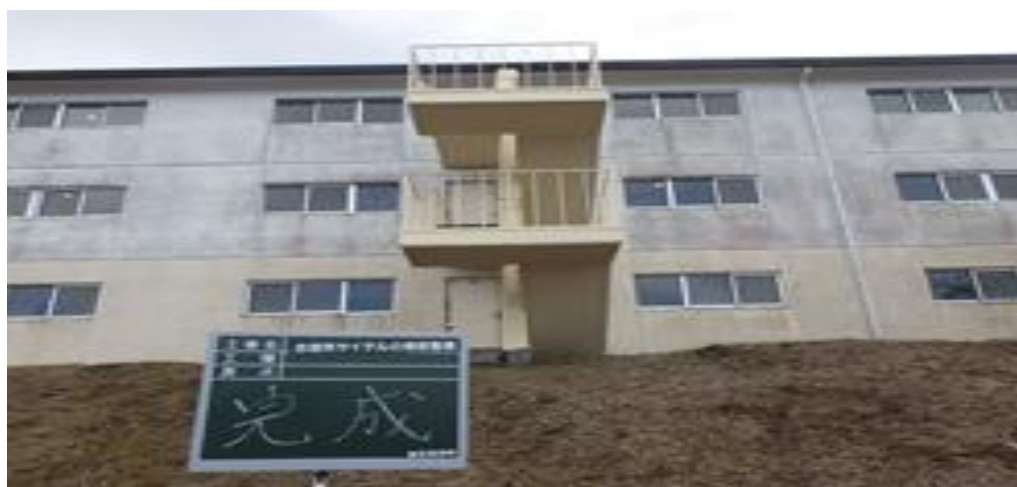
(完成写真 ⑤非常階段)
