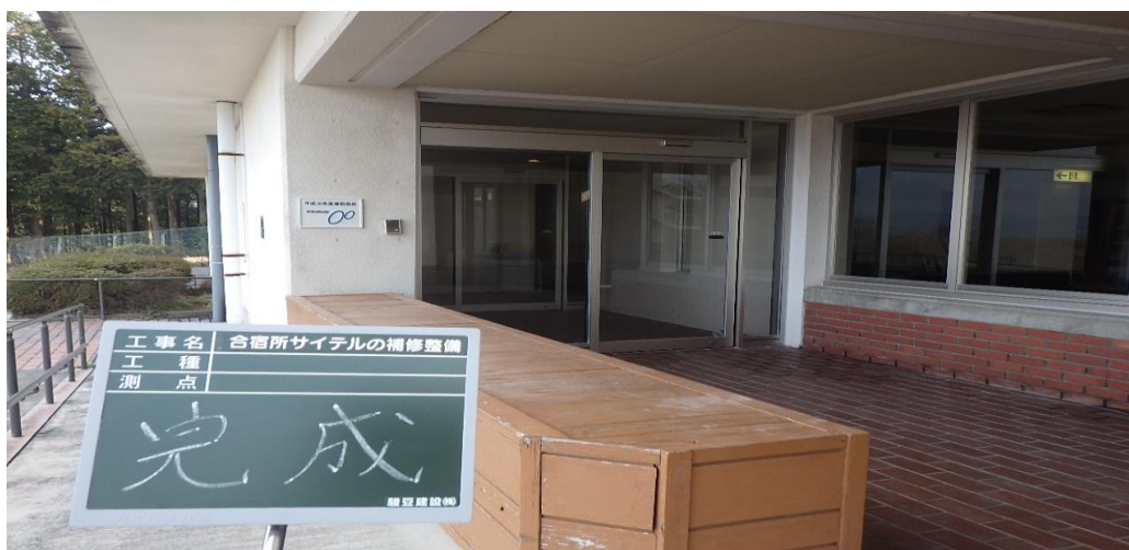
(完成写真 ①玄関)
